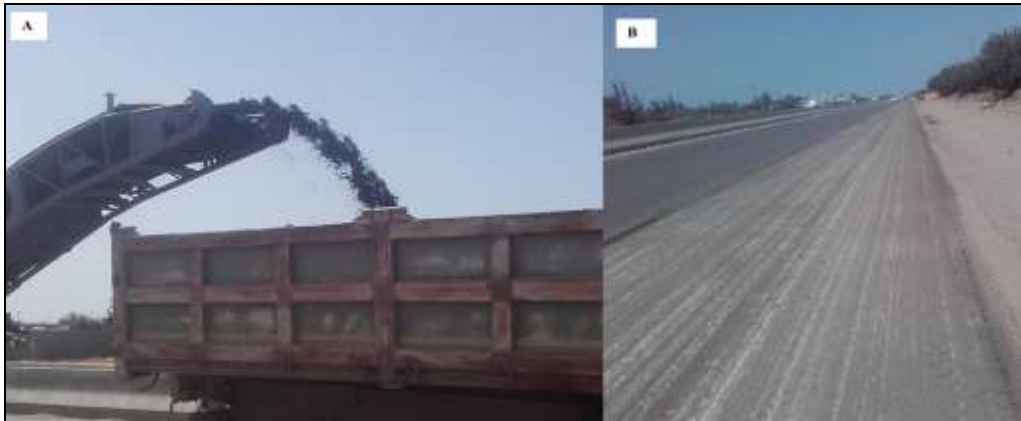
الشكل 1: يوضح عملية صيانة الطريق بواسطة آلة الطحن (a) و الطريق بعد القشط (b).
