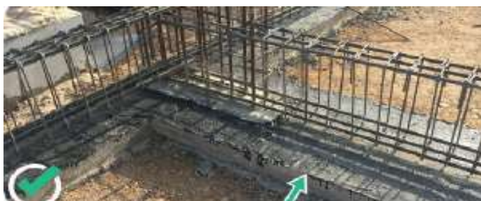
شكل (19) : خرسانة النظافة تحت الميد بعد صبها وعزلها (الجند، 2021)
