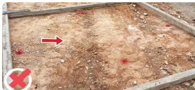
شكل (6) : الاستعداد لصب خرسانة النظافة من دون تسوية التربة (الجند، 2021)
