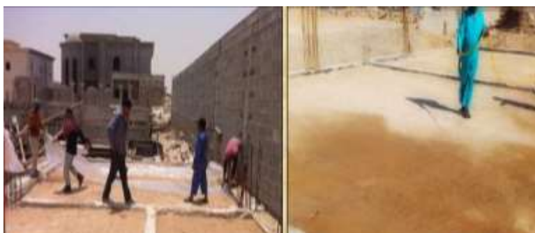
شكل (23) : رش مبيد حشري ثم تغطيته بنايلون تمهيداً لصب خرسانة الأرضيات (رزق، 2014)
