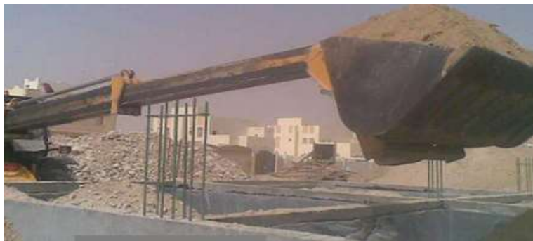
شكل (20) : تجاهل عزل الميـد قبل الردم (رزق، 2014)
