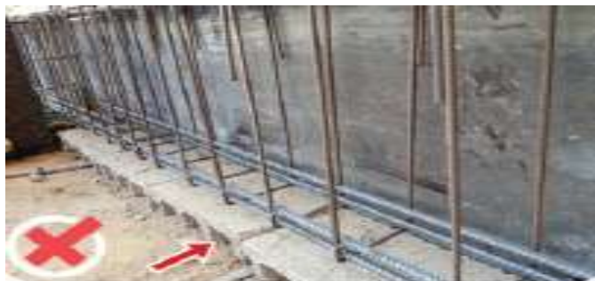
شكل (18) : وضع بلوك أسفل الميد مباشرة كطبقة نظافة (الجند، 2021)
