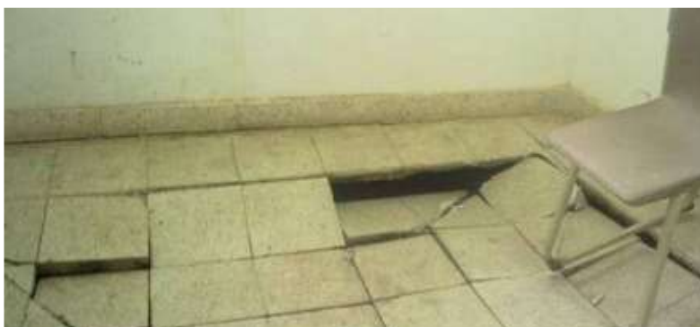
شكل (21) : هبوط أرضية الدور الأرضي بسبب إهمال المواصفات الفنية للردم (رزق، 2014)
