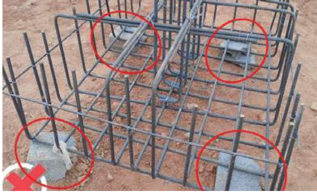
شكل (8) : رفع حديد التسليح فوق التربة باستخدام طوب بارتفاع 10سم بدلاً من صب خرسانة النظافة (الجندي، 2021)
