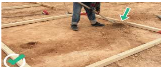
شكل (7) : الاستعداد لصب خرسانة النظافة بعد تسوية التربة وإزالة الأتربة المخلخلة (الجند، 2021)
